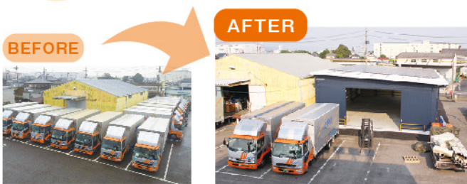
新倉庫が建つ前は駐車場でした。(※黄色い倉庫の横に建設しました)
