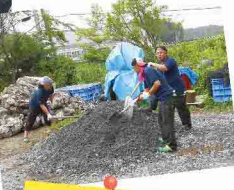
2016年当時、まだ整備が行き届いていない敷地・仮設住宅がありました。みんなで水はけ用の砂利を引いたり、穴を掘ってパイプを通したりしました。
