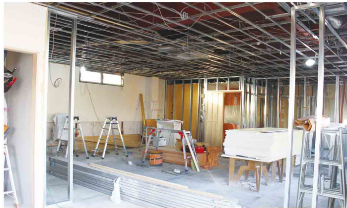
本社1階の工事の様子です。これからこの1階が大変身する予定です。
