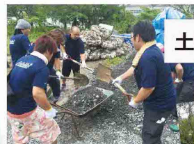
2016年当時、まだ整備が行き届いていない敷地・仮設住宅がありました。みんなで水はけ用の砂利を引いたり、穴を掘ってパイプを通したりしました。
